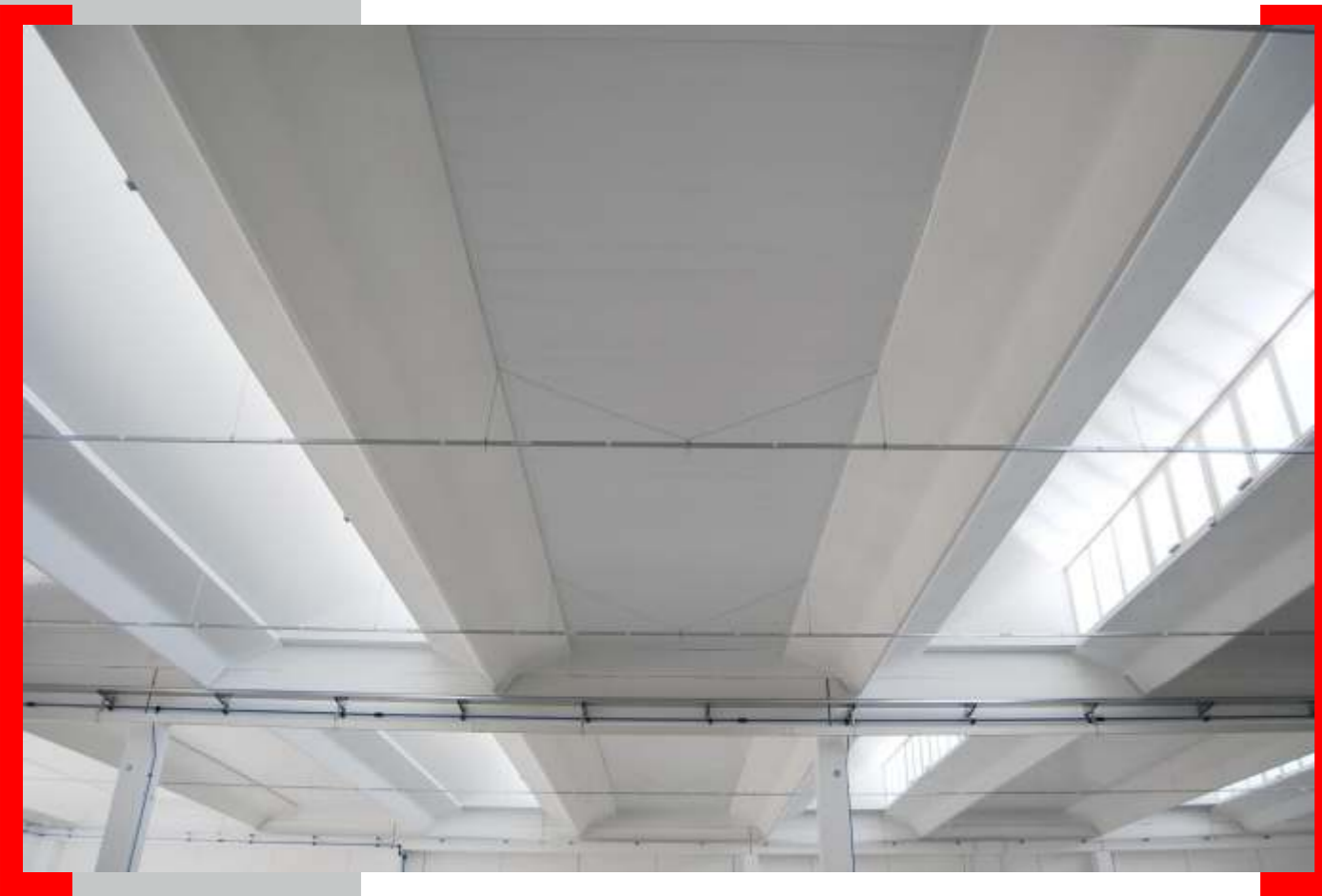
Immagini in alto: vista intradosso con Macroshed e controsoffitti con lastra dogata.
