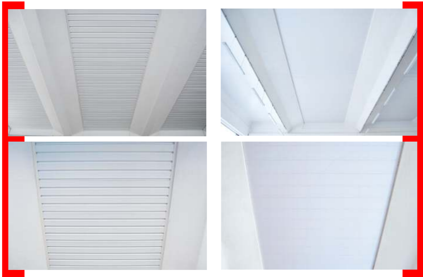
Immagini in alto : viste intradosso Silver con controsoffitti imbiancati con lastre grecate e dogate
