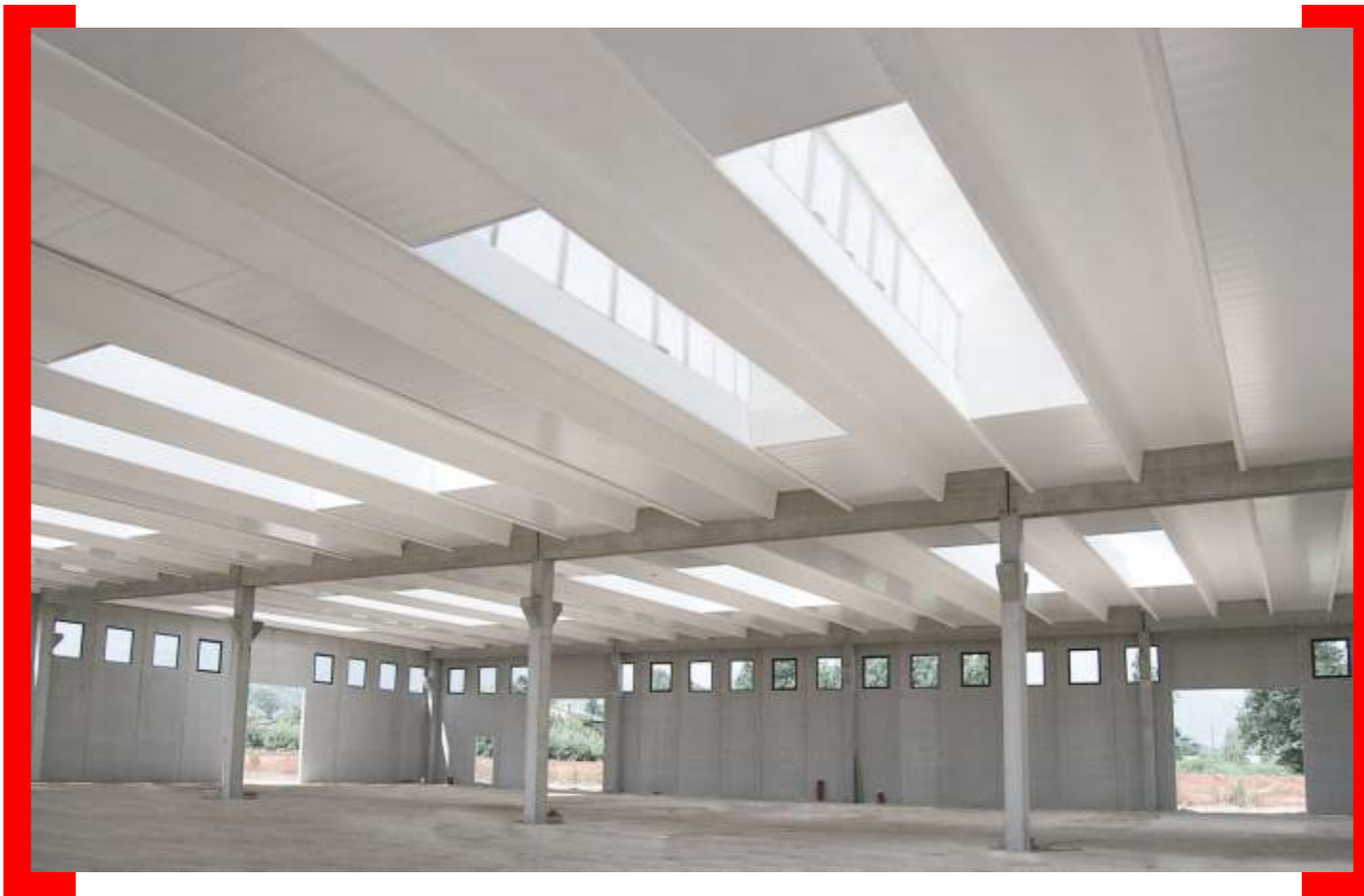
Immagine in alto: vista intradosso soluzione con Macroshed
